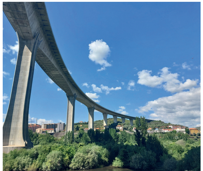
Hoch hinaus - Ponte Miguel Torga
