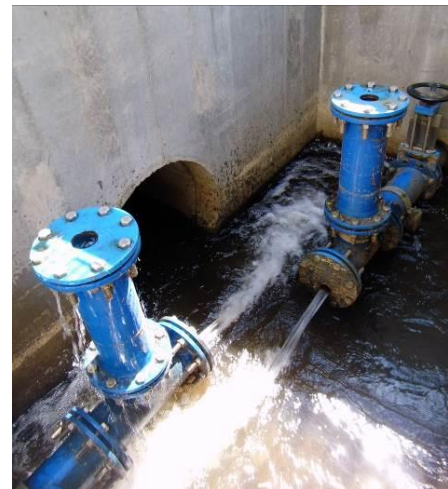
Ablaufbauwerk mit einfachen Drosseln und Überlauf
