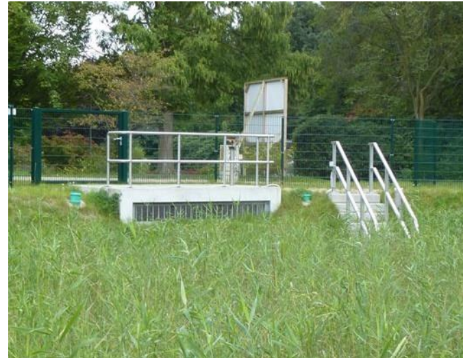
Ablaufbauwerk mit einfachen Drosseln und Überlauf
