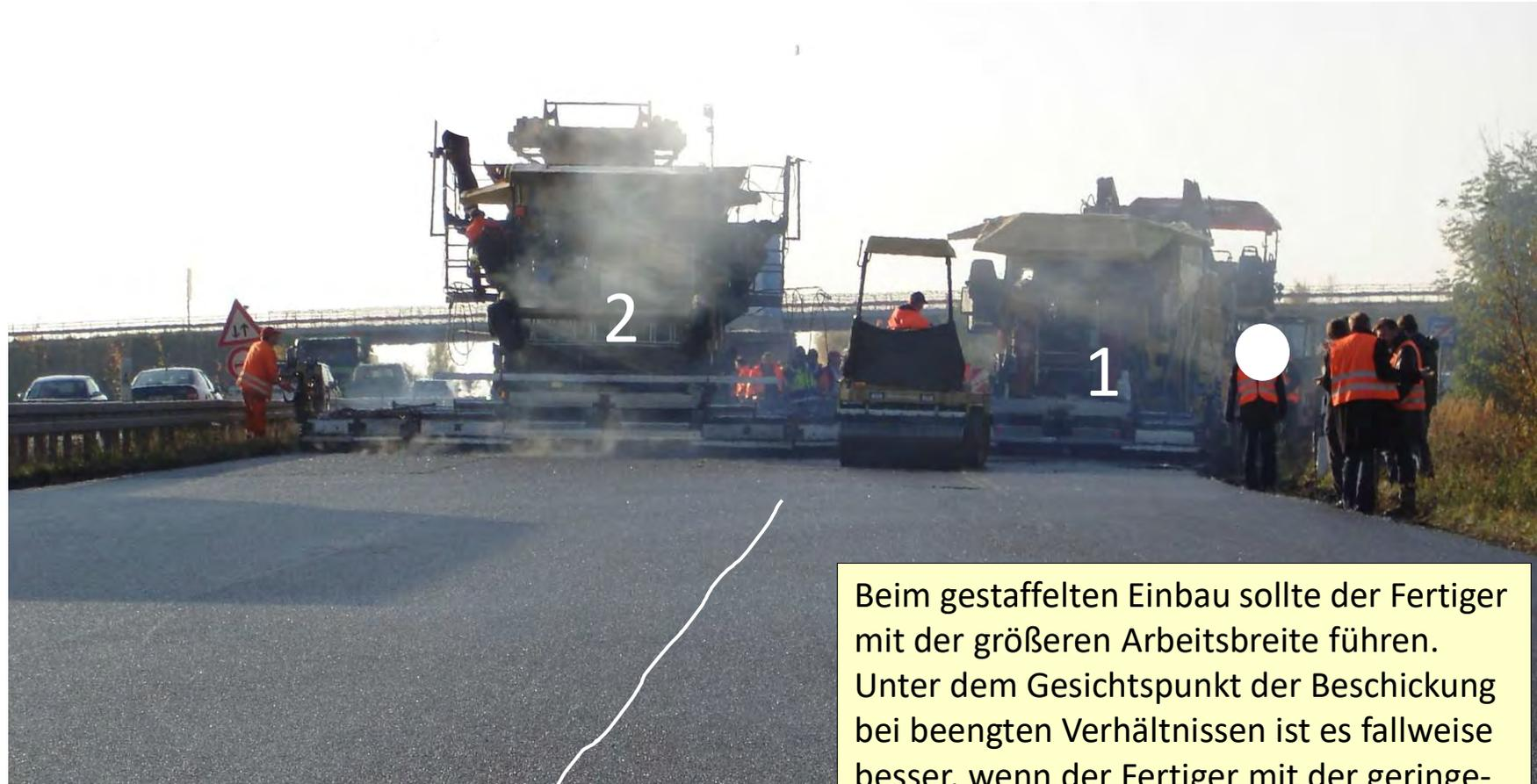
Beim gestaffelten Einbau sollte der Fertiger mit der größeren Arbeitsbreite führen. Unter dem Gesichtspunkt der Beschickung bei beengten Verhältnissen ist es fallweise besser, wenn der Fertiger mit der geringeren Arbeitsbreite führt. Dann ist die Art der Nivellierung zu überdenken.
