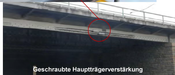
Blechausschnitt zur Vermeidung von Risswachstum
