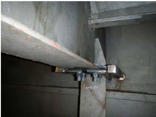
Instandsetzung und Ertüchtigung von Stahlbrücken
