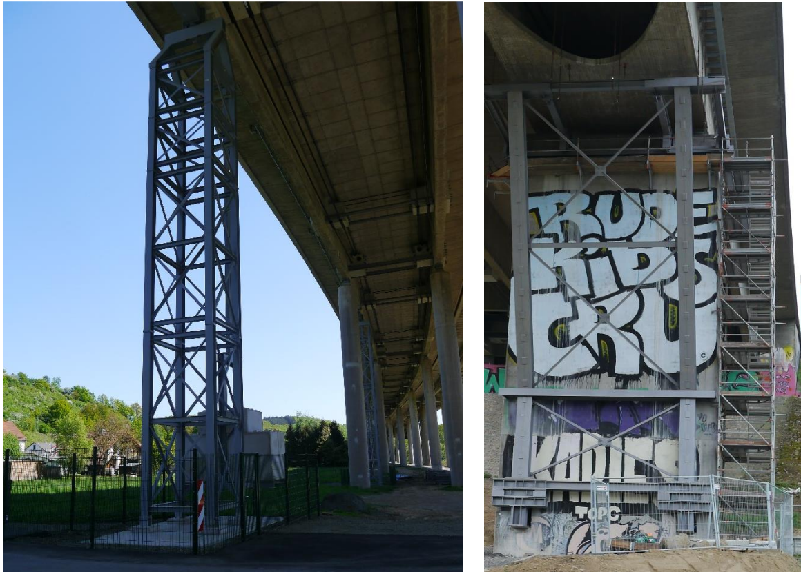
Abbildung 1: links) umgesetzte Verstärkungsmaßnahme an der Talbrücke Sechshelden, rechts) sich im Bau befindende Verstärkungsmaßnahme an der Salzachtalbrücke
