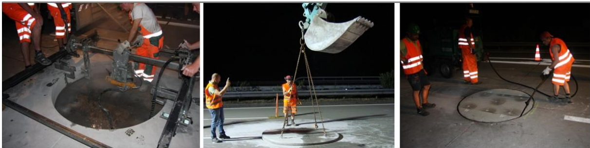
Abbildung 8: Einbau eines Betonfertigteils auf einer Bundesautobahn (Photos: M. Wieland)
