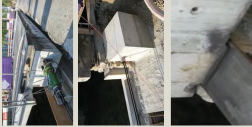
Bsp 1 – Brücke Biel, CH Verschubgeräte: Litzeneheber Verschubart: Teflon auf Stahl
