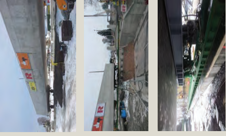
Bsp 4 – Unterführung Lustenau, Österreich Verschubgeräte: APS-System Verschubart: Elastomer auf Stahl
