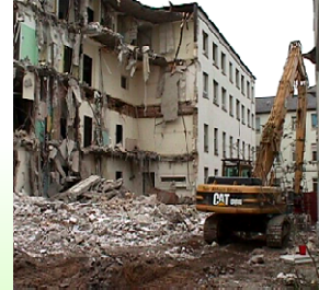
Rückbau: separate Fraktionen
