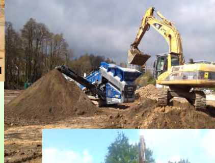
Siebanlage zur Trennung von Bauschuttanteilen aus Auffüllböden
