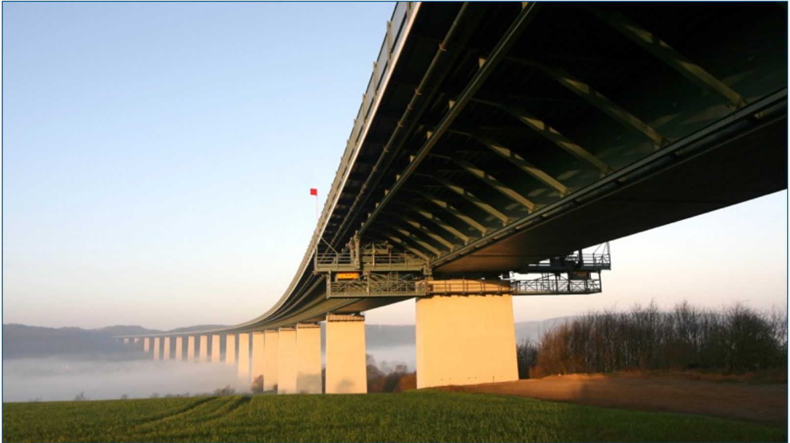
Talbrücke Mintard, A52
