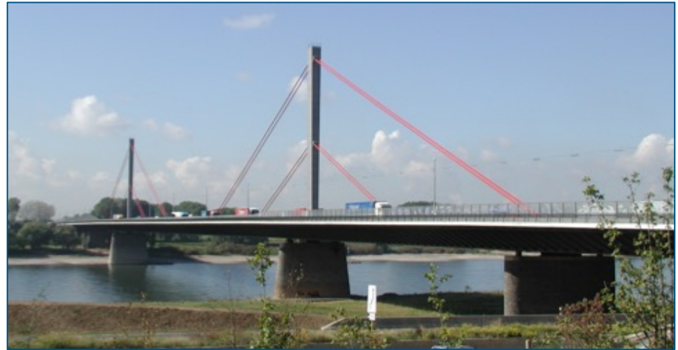
Rheinbrücke Leverkusen, A1
