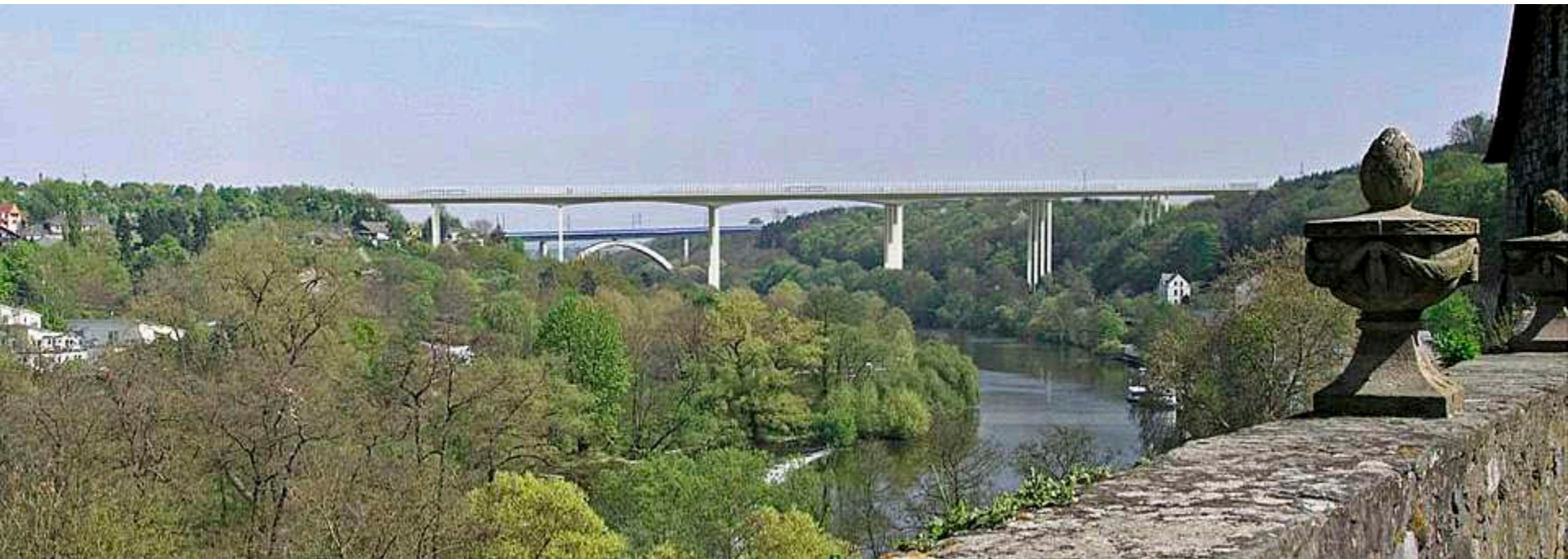
Lahntalbrücke Limburg, A3
