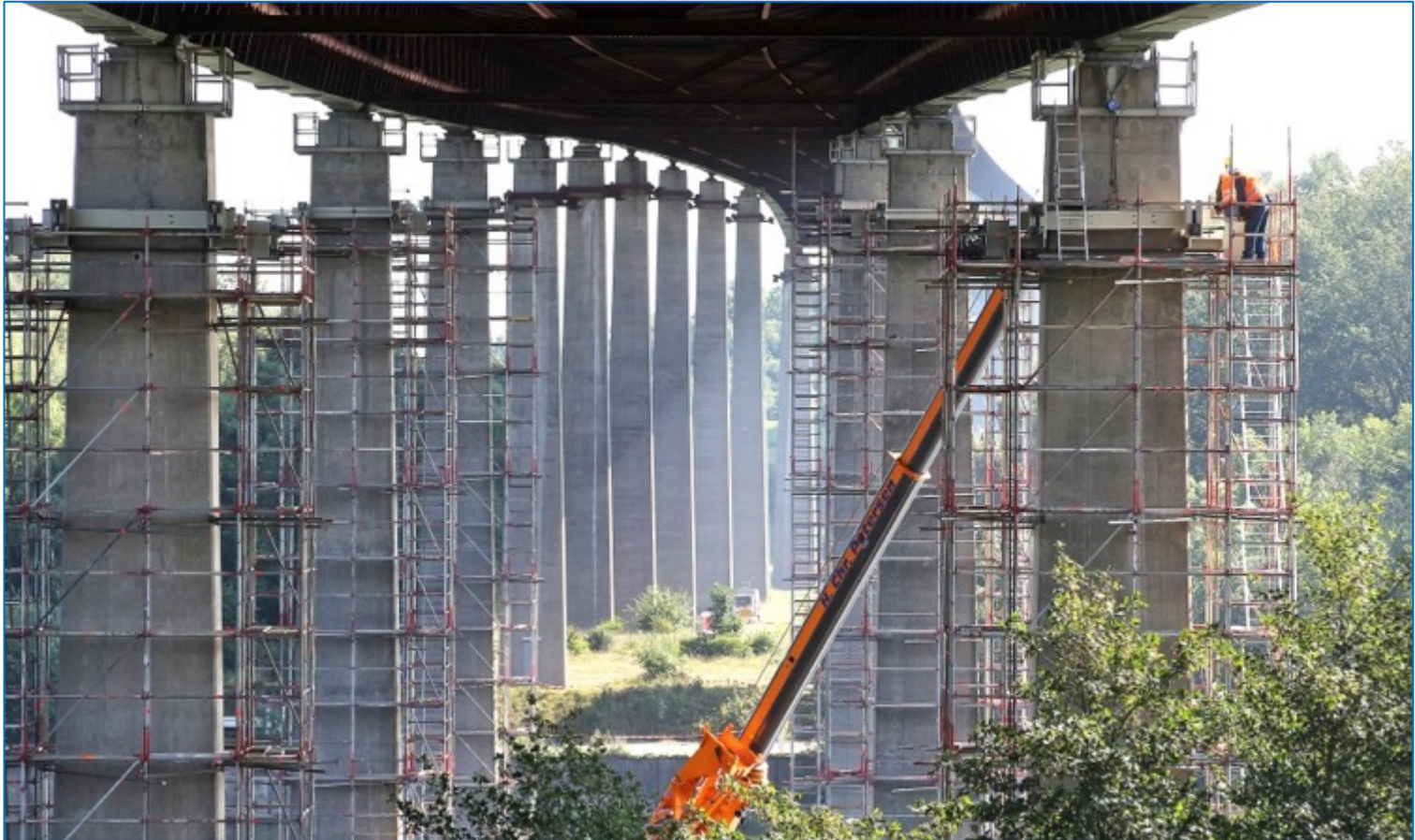
Rader Hochbrücke, A7
