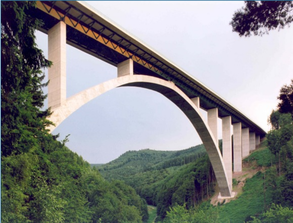
Talbrücke Wilde Gera, A71
