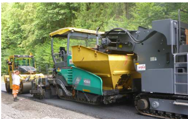
Foto 3 und 4: Einbaugeräte Walze, Fertiger mit Beschicker und Thermotransportmulde
