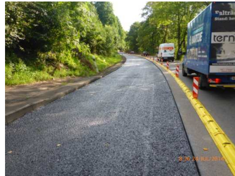
Foto 1 u. 2: Verkehrssicherung durch Leitschwellen als Längsabgrenzung
