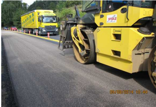
Foto 1 u. 2: Verkehrssicherung durch Leitschwellen als Längsabgrenzung
