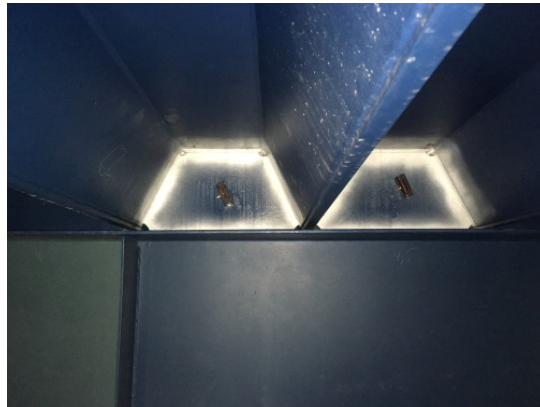
Sensoren während der Installation
