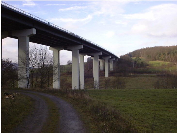
Seitenansicht der Thalaubachtalbrücke
