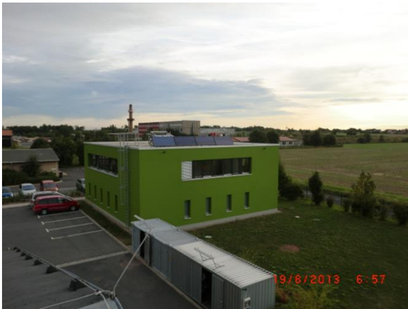
Bild 6: SM Großenhain Dienstgebäude mit Solarthermie
