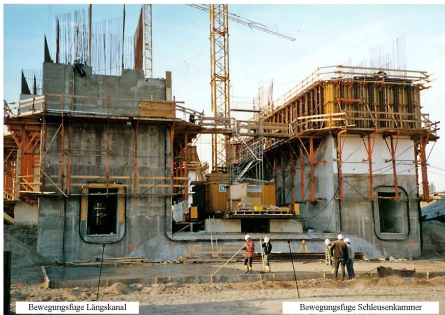
Bild 1: Fugenbandsituation beim Neubau einer Schleuse
