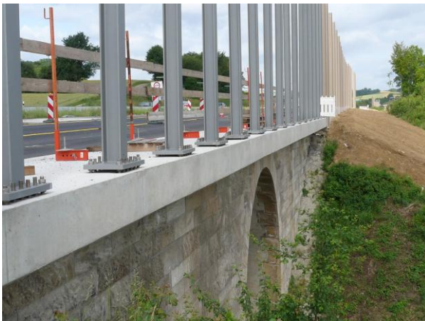
Befestigung der Lsw-Pfosten auf der Brückenkappe;
