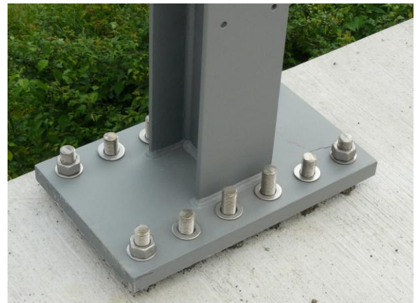
Detail Fußplatte mit Anker
