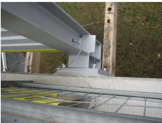
Lärmschutzwand vor der Brückenkappe; Seilsicherung für die LS-Elemente (BAB A6_Weinsberger Kreuz)
