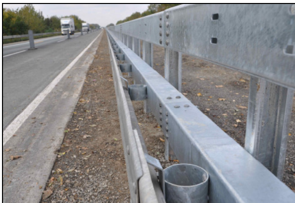
Bild 1: Moderne Schutzrichtungen aus Stahl und Beton (Foto links: Gütegemeinschaft Stahlschutzplanken e.V., Foto rechts: WALL STOP)
