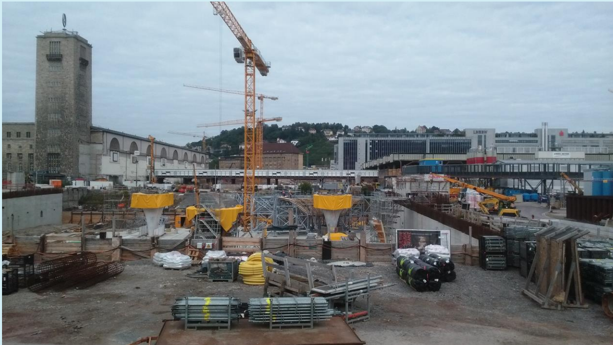
Bahnsteige mit Kelchstützen DB AG Stuttgart 21 (Bild privat)
